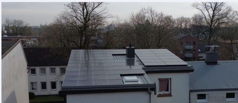
Foto 11: PV-Anlage Feldstr. 15 | © Stadt Elmshorn
