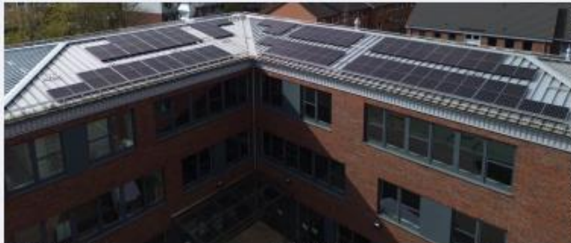
Objekt: AFS in Betrieb genommen: 2024 Anlagengröße: 59.84kWp Bisher erzeugt: 31.683kWh
