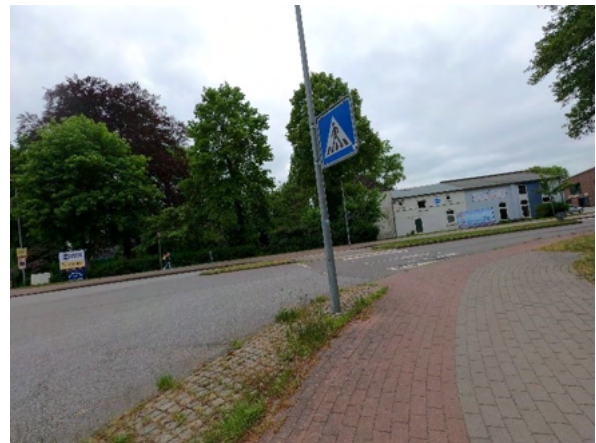
Abbildung 48: Unbefestigte Geh- und Radwege in der Ollnsstraße (links) und weit eingerückte Querungsstelle im Bereich Koppeldamm/ Kaltenweide
