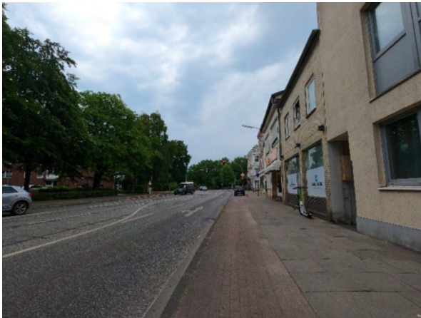
Abbildung 61: Fehlender Sicherheitstrennstreifen (links) und Sicherheitstrennstreifen sowie taktil erfassbarer Streifen im Adenauerdamm (rechts)
