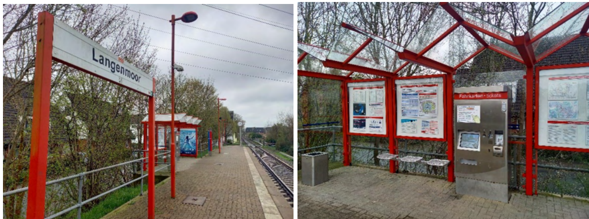
Abbildung 82: Ansicht des AKN-Haltepunktes Langenmoor
