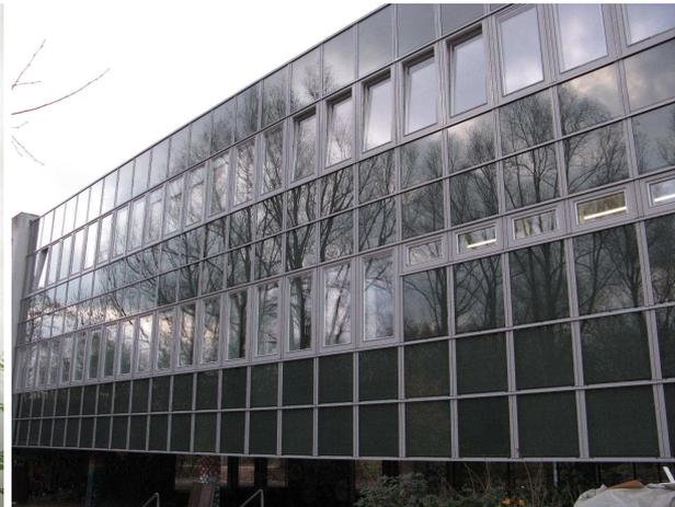
Abbildung 22 Die neue GAP-Solar-Fassade
